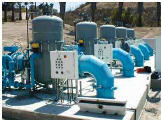
90型管道过滤器可使用碳钢、不锈钢、蒙乃尔合金、哈氏合金“C”和其他材料制造而成。该过滤器适用于1英寸至48英寸的管道系统。
